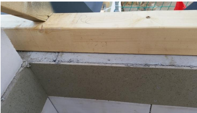
Rissbildung Vergrößerung aus dem Bild links
