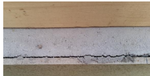
Rissbildung Vergrößerung aus dem Bild links
